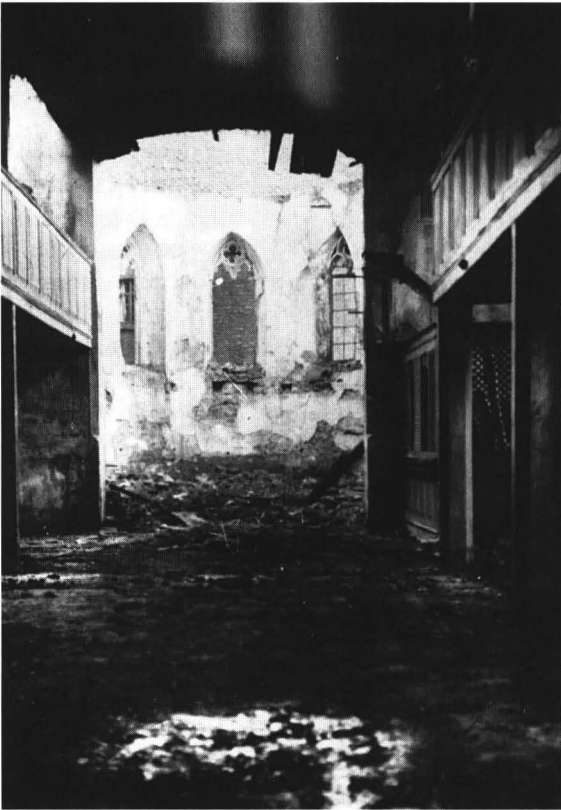
Innenraum der Düdelsheimer Kirche nach dem Brand 1919
