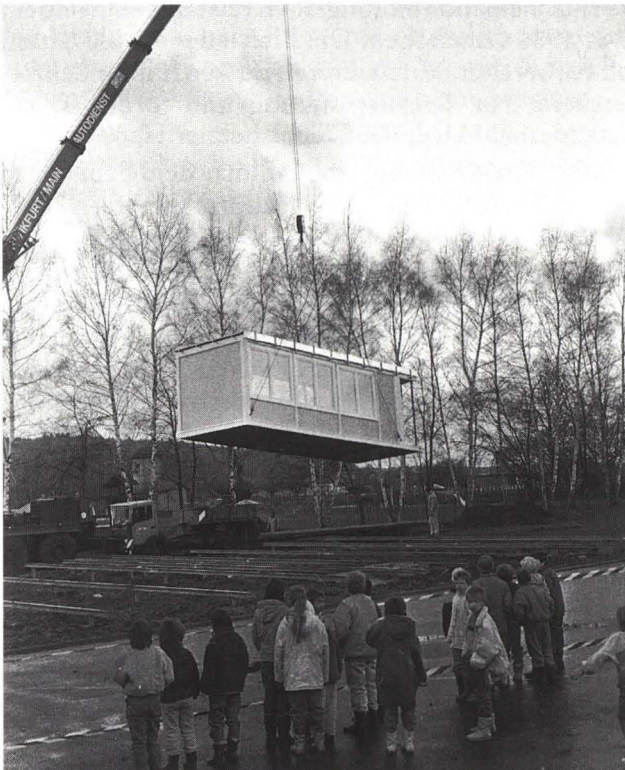
Erweiterung der Georg-August-Zinn-Schule in Düdelshcim
